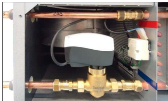
4. Frosttermostat (B3) monteret på vand- eftervarmeflade.
