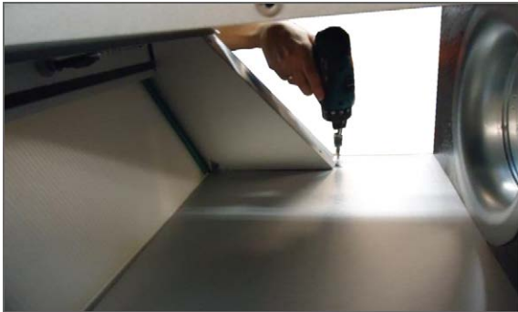
1. Filterramme for fraluftfilter trækkes ud. Kabelafskærmning demonteres (illustration 1).
